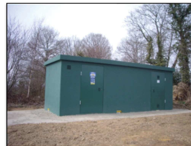
Figure 4 : Exemple de poste de livraison
