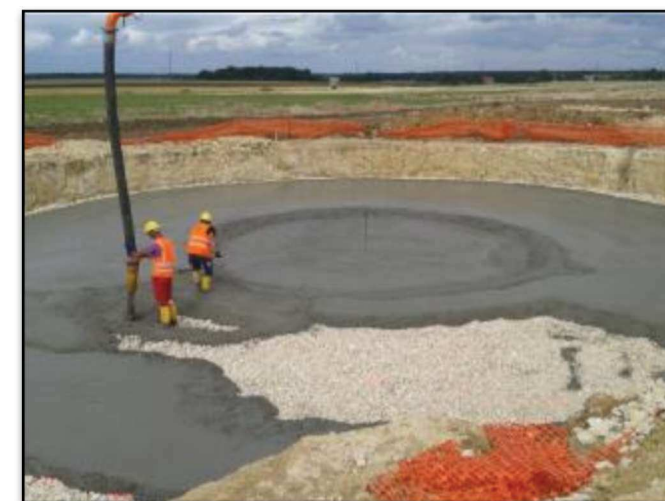
Figure 10 : Coulage du béton de propreté (à gauche) et ferrailage du massif de fondation (à droite)
