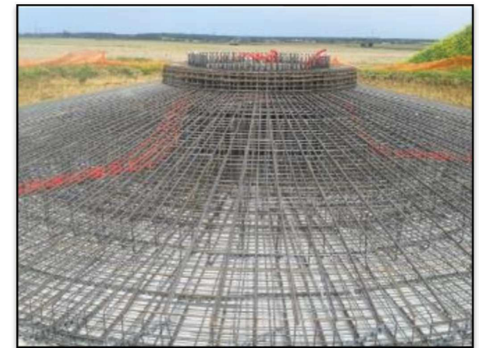
Figure 10 : Coulage du béton de propreté (à gauche) et ferrailage du massif de fondation (à droite)
