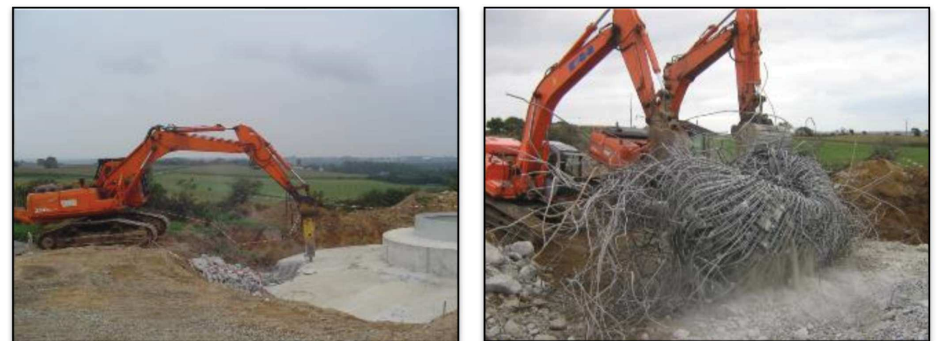
Figure 17 : Eclatement des fondations (à gauche) et enlèvement du ferrailage (à droite)
